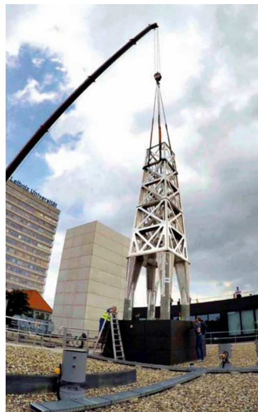
Das entstehende Atominterferometer an der Universität Hannover: Installation des Haltegerüsts für die sogenannte VLBAI-Versuchskammer
